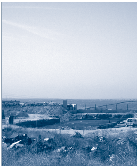
Las obras del nuevo campo de fútbol marchan a buen ritmo
