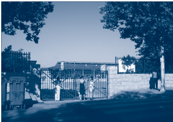
En el colegio Fuente Santa se realizarán tareas de pintura de las instalaciones.
