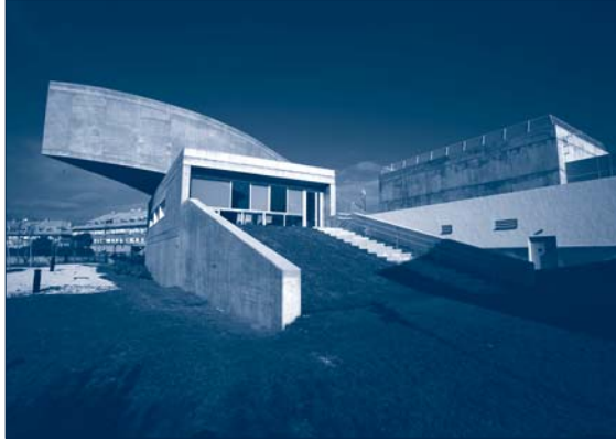
La nueva instalación tiene 2.300 m 2 de superficie repartidas en tres plantas
