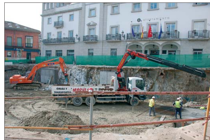
Una de las actuaciones previstas en el Presupuesto 2009 es la ejecución de la fase final de remodelación de la Plaza del Pueblo.
