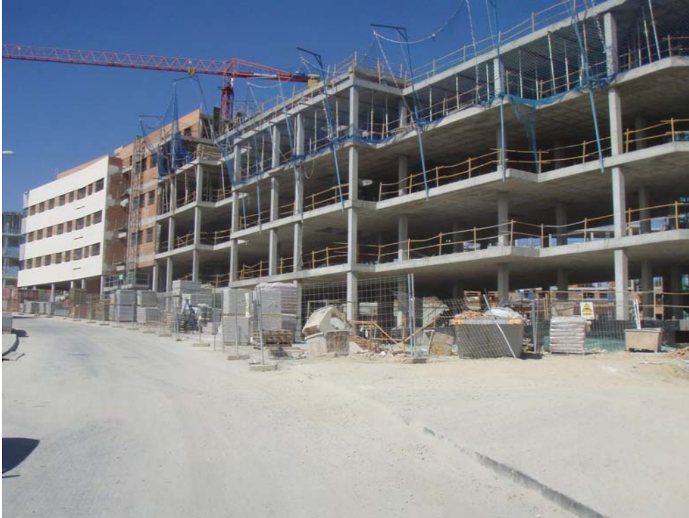
Vista edificio 3 desde Calle Agapito García "Serranito"
