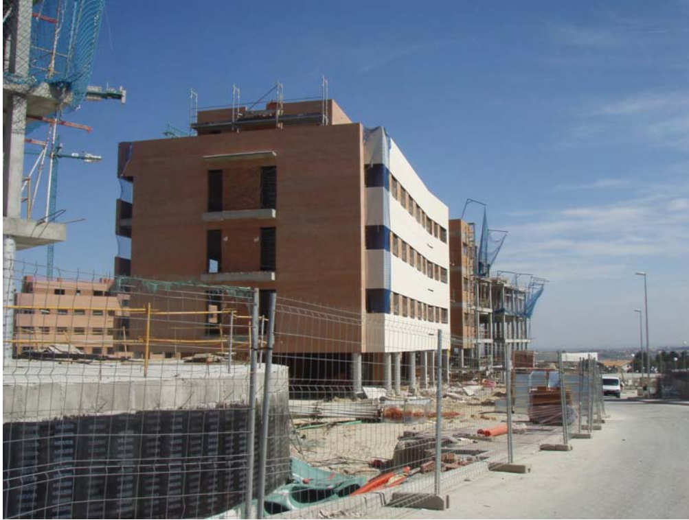
Vista del edificio 3 desde la Calle Agapito García “Serranito”
