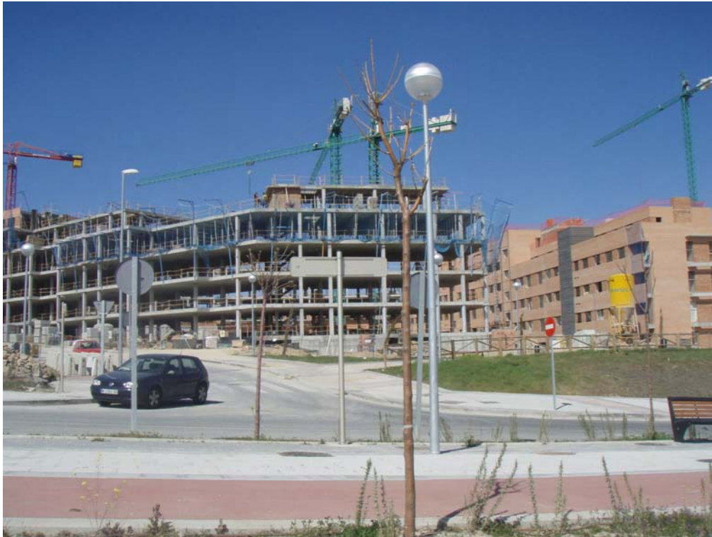
Vista de los 3 edificios desde la Avda. de Juan Pablo II
